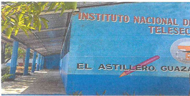
Foto 3. Demolicion y restitution de piso de concreto
