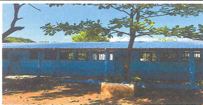
Foto.5, sustitucion de techo con estructura metalica y enlaminado
