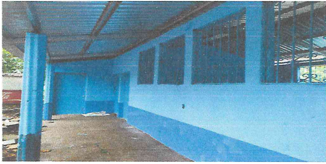
Foto 1. Ilijado y pintado de balcones
