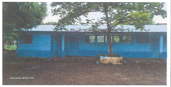
Foto, 4 cambio de lámina a lámina troquelada
